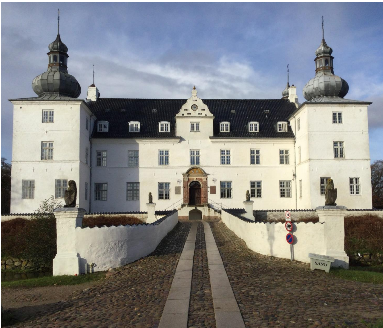
Engelsholms hovedbygning, november 2023. Slottet blev opført i 1593, en rektangulær bygning med en regulær grundplan og et kvadratisk tårn i hvert hjørne. Astronomen Tyge Brahe var involveret i opførelsen af Engelsholm Slot. Engelsholm er i dag indrettet som højskole. Foto: Elmo Flaskager, 2023.
