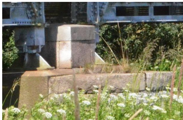
Fundament under jernbanebroen mellem Skjern og Tarm. Foto: Arkvest.
